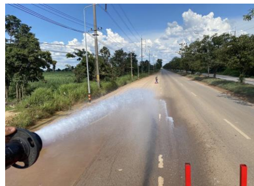
รูปที่ 9 รถบรรทุกฉีดพรมน้ำบริเวณพื้นที่ก่อสร้าง
