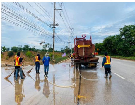
รูปที่ 10 จุดล้างล้อรถก่อนออกนอกโครงการ
