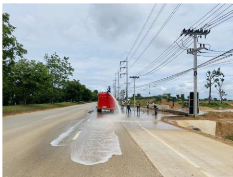
รูปที่ 9 รถบรรทุกฉีดพรมน้ำบริเวณพื้นที่ก่อสร้าง
